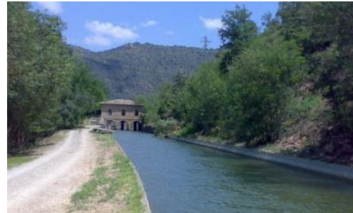
Fließgewässer | Talsperren | Bewässerung
