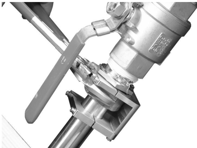
Abb. 10-37 Überwurfmutter lösen zum Sensorausbau
