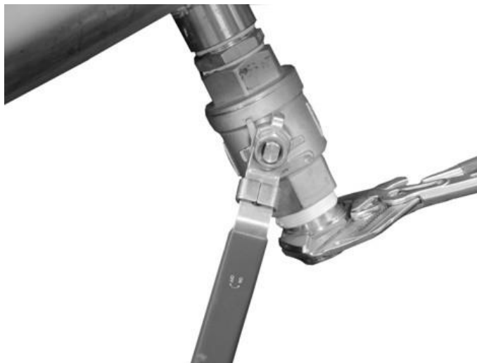
Abb. 10-31 Sensorverschraubung am Kugelhahn anbringen
