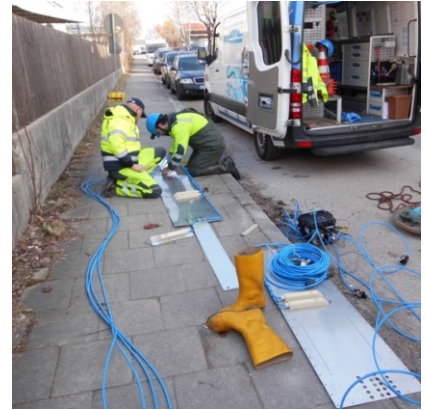
Vorbereitungen für Durchflussmessereinbau
