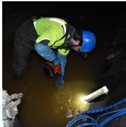
Einbauarbeiten im Kanal
