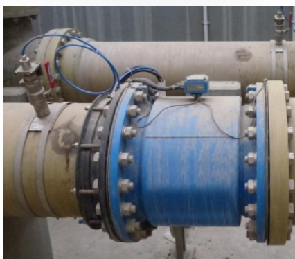
Installation mesure de débit par ultrasons avec NFP
