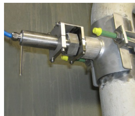
Installation mesure de débit par ultrasons avec NFP
