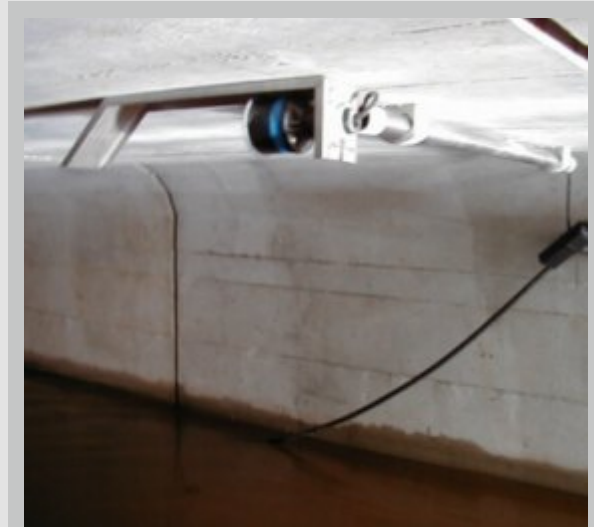
Mesure de niveau ultrasonique avec réflecteur passif
