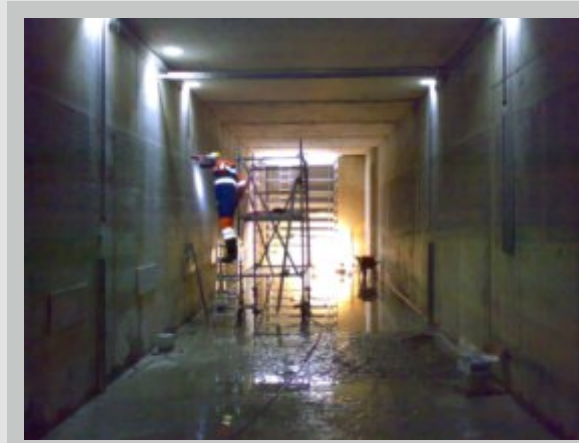
Montage des capteurs dans le canal
