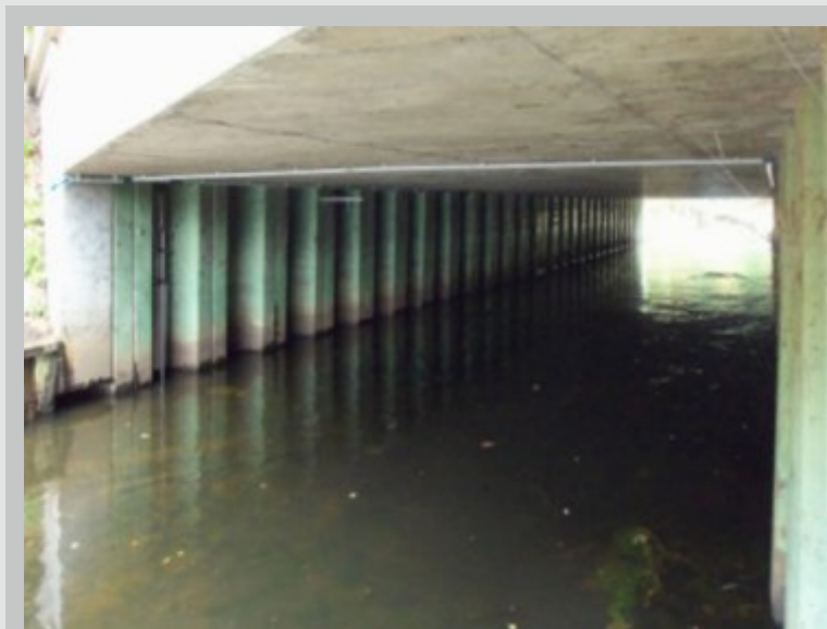
Situation de montage sous le pont
