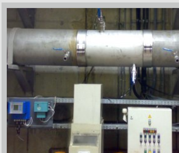
Mesure sur deux cordes par différence de temps de transit
