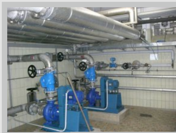
Vue des échangeurs thermiques
