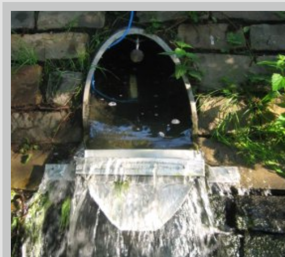
Conduite d'écoulement avec tôle de retenue
