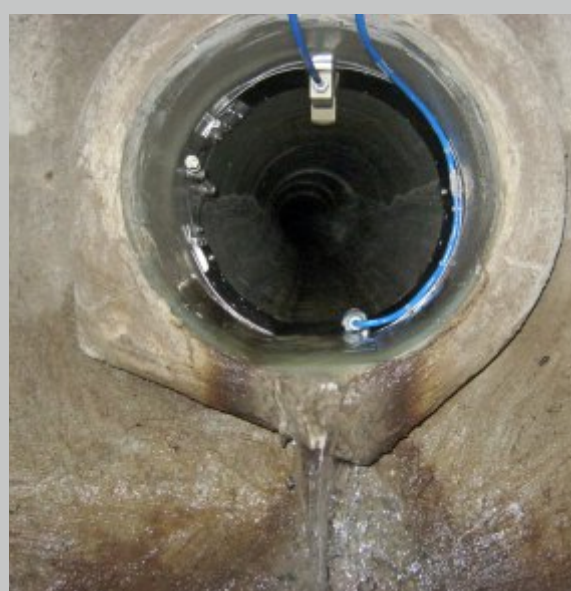
Installation avec système de montage sur conduite
