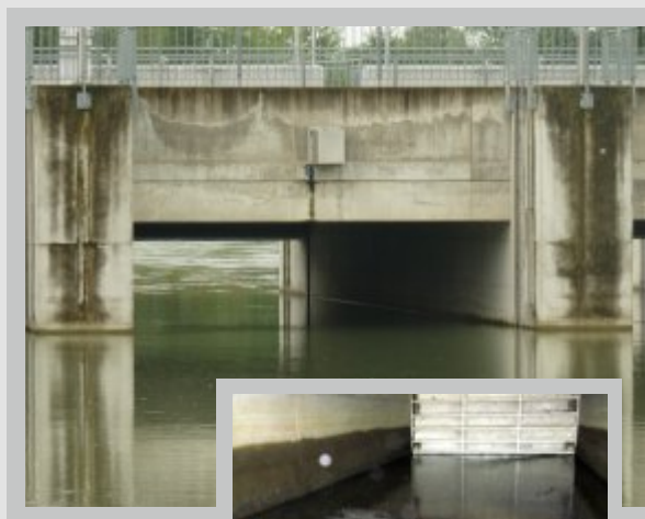
Porte de polder avec capteurs installés
