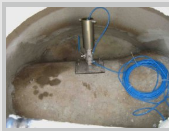
Puits de mesure avec armature de dégagement installée
