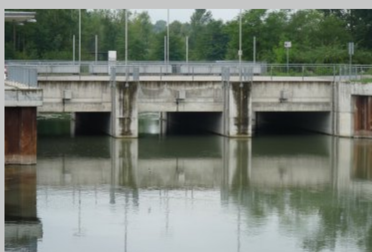
Vue des 3 portes des polders partiellement remplis
