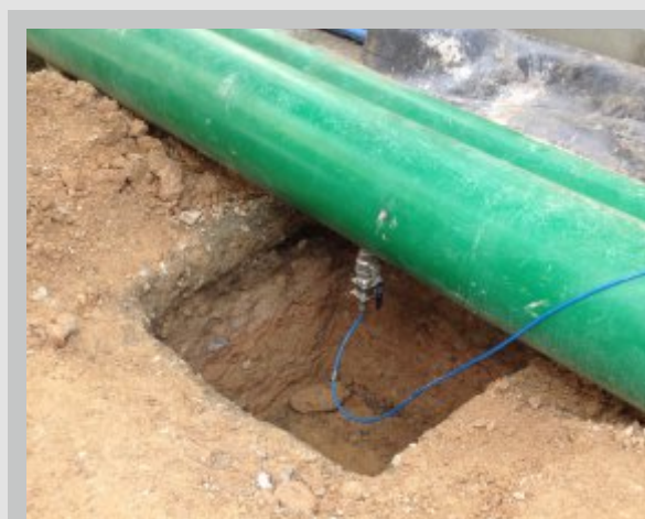
Capteur installé
