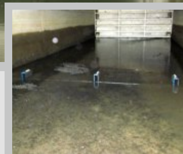
Porte de polder avec capteurs installés
