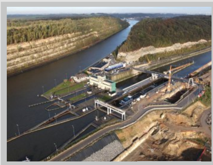
Aperçu de l'écluse
