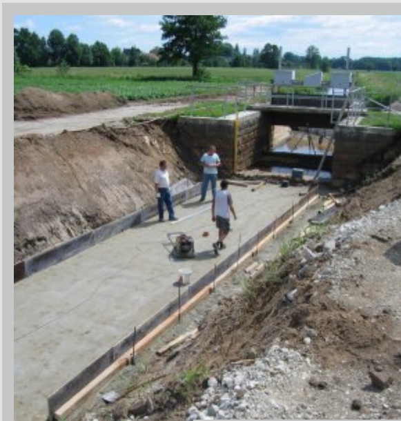
Point de mesure en chantier
