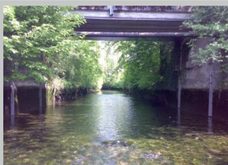
Point de mesure à proximité d'un pont
