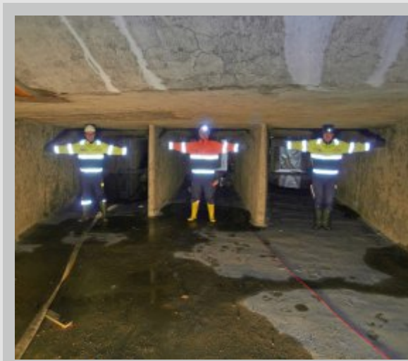
Vue du site d'installation
