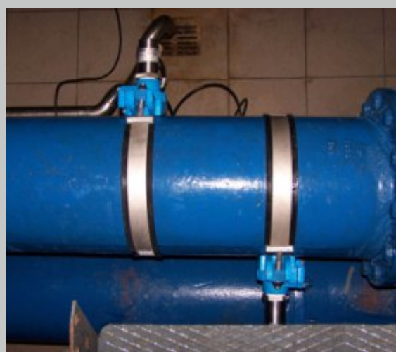
Remplissage et vidange de la conduite avec capteurs installés
