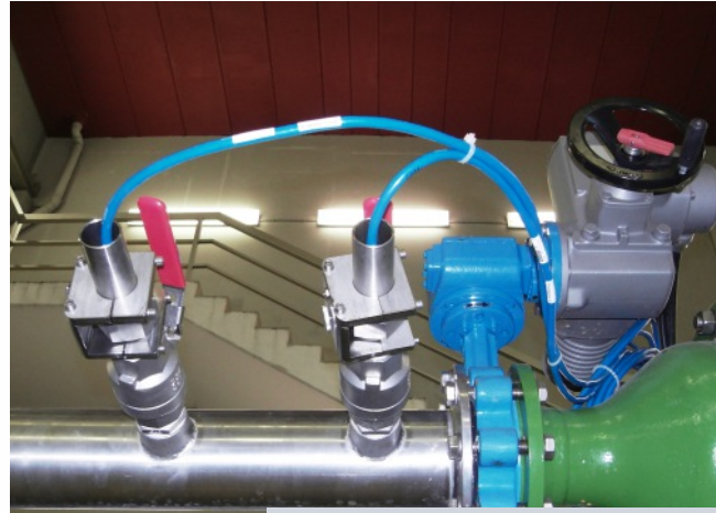
Mesure de la distribution nocturne par une corde de mesure
