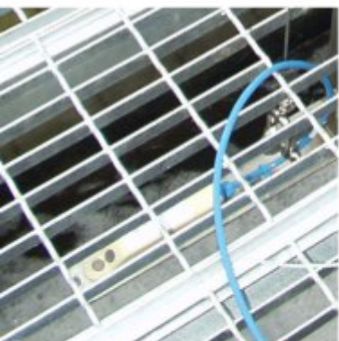
Dispositif de levage lors de contrôles ou de dépose du capteur en cours d'exploitation
