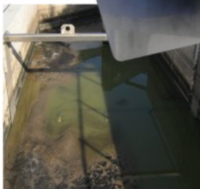
Dispositif de levage lors de contrôles ou de dépose du capteur en cours d'exploitation
