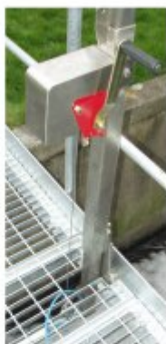
Dispositif de levage lors de contrôles ou de dépose du capteur en cours d'exploitation
